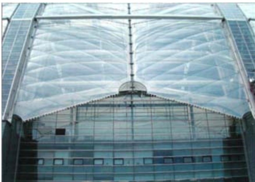
Ved "foden" af ETFE-foliepuderne på Tropical Islands; foto: formTL, Radolfzell
